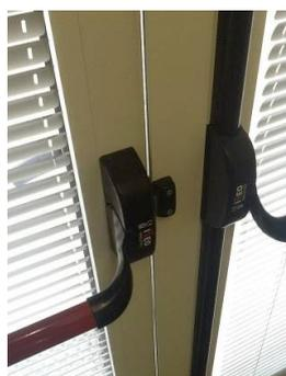
Le uscite di emergenza sono raggiungibili con una distanza non superiore a quanto previsto dal D.M. 26/08/1992 ("Norme di prevenzione incendi per l'edilizia scolastica"). Al momento dell'ultimo sopralluogo le vie di fuga e le uscite di emergenza sono risultate sgombre da ostacoli.
