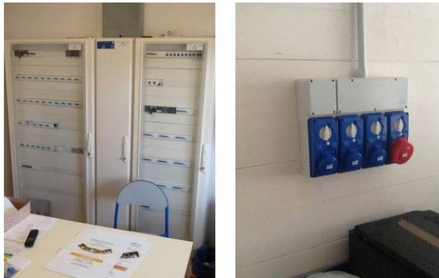
Tutti gli utilizzatori sono protetti da interruttori differenziali con  $I_{dn} = 0,03 - 0,3$  A. Le prese multiple ed i cavi elettrici volanti sono ridotti al minimo; le prese sono in genere di tipo adeguato alle utenze elettriche che alimentano. Presenti anche pulsanti per lo sgancio automatico dell'impianto elettrico in caso di emergenza.
